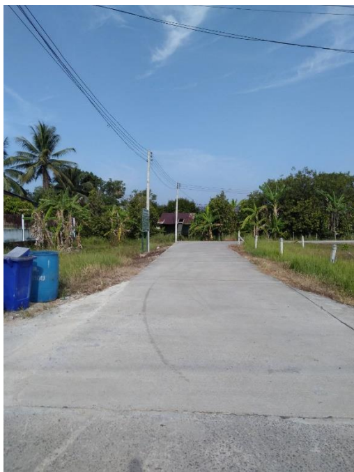
โครงการขยายเขตไฟฟ้าสาธารณะ ซอยหม้ออ้อย หมู่ที่ ๙
